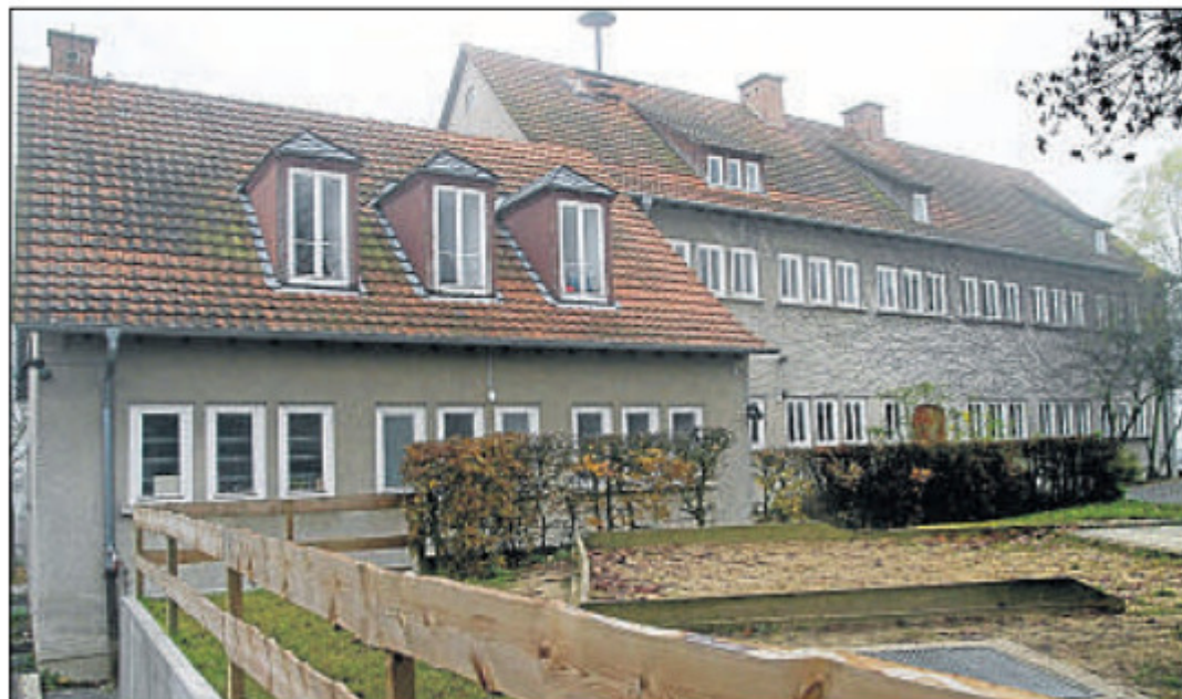
Zentrales Projekt der Dorferneuerung: Das Haus der Vereine soll zum Haus der Begegnung umgebaut werden, hier ist die rückwärtige Seite zum Schulhof hin zu sehen.
