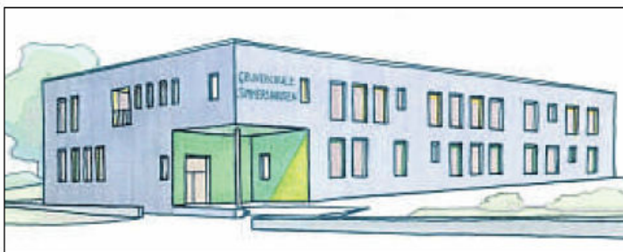
Keine Lichtbänder mehr: Der sanierte Schulbau samt Anbau mit neuem Eingang (links) hat eine gedämmte Fassade mit Einzelfenstern. Entwurf: Büro RSE Kassel
