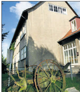
Zentrales Projekt: Die ehemalige Schule in der Dorfmitte soll vom Landkreis übernommen und nach Umbau sowie Sanierung zum Haus der Begegnung werden.
